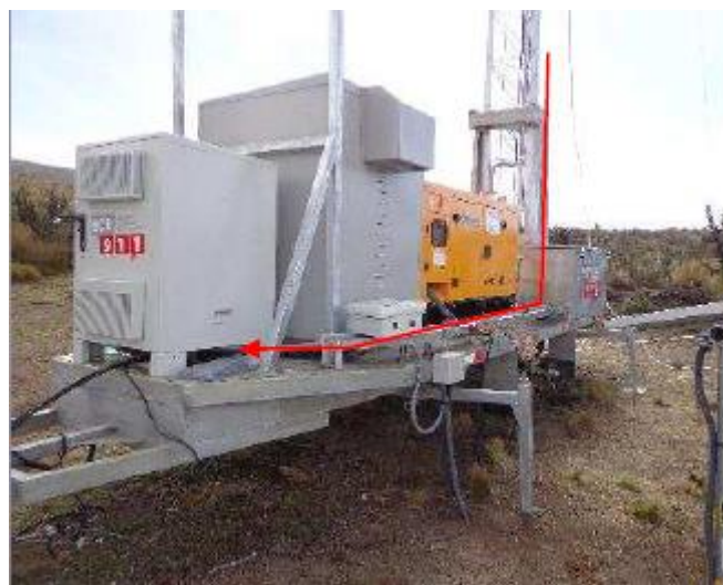
Figura 3. Imagen de la base de la torre.
