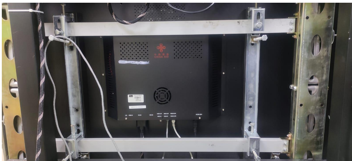
Soportes y rieles preexistentes que cuenta la institución actualmente
